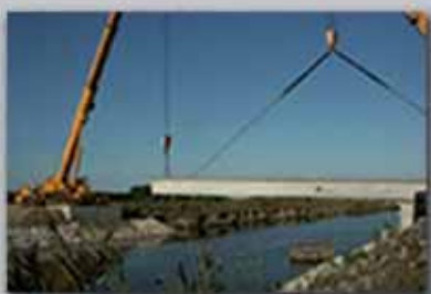
Ponte sul collettore Mezzano
