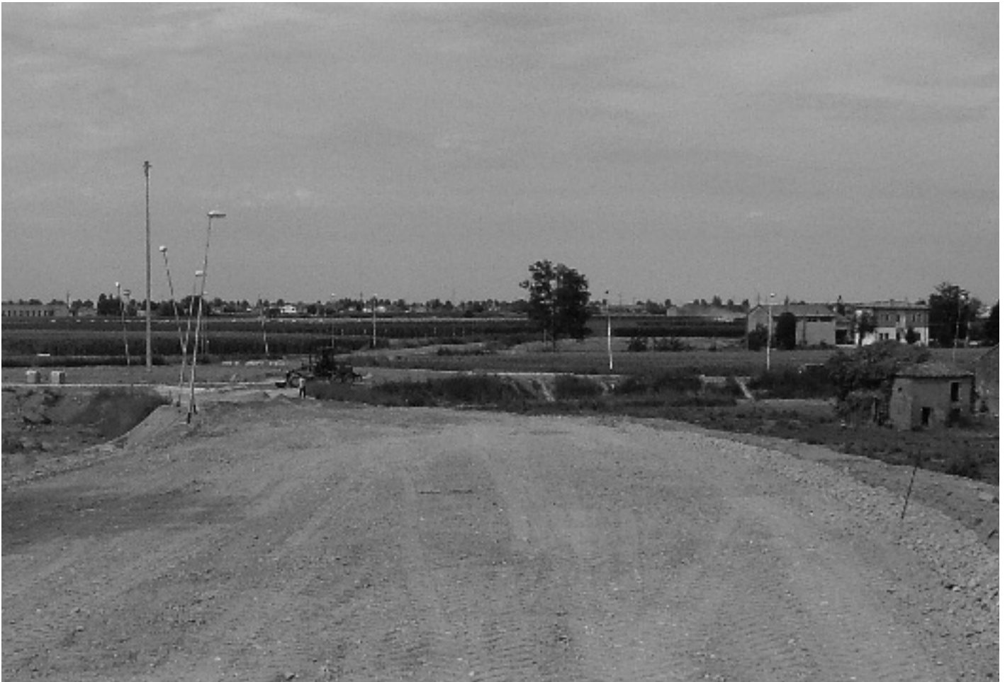
Uno dei cantieri aperti in provincia di Ferrara
